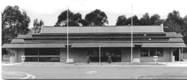
KOB podczas budowy i po jej zakończeniu (1970-71) | zdj. J Zawartko
