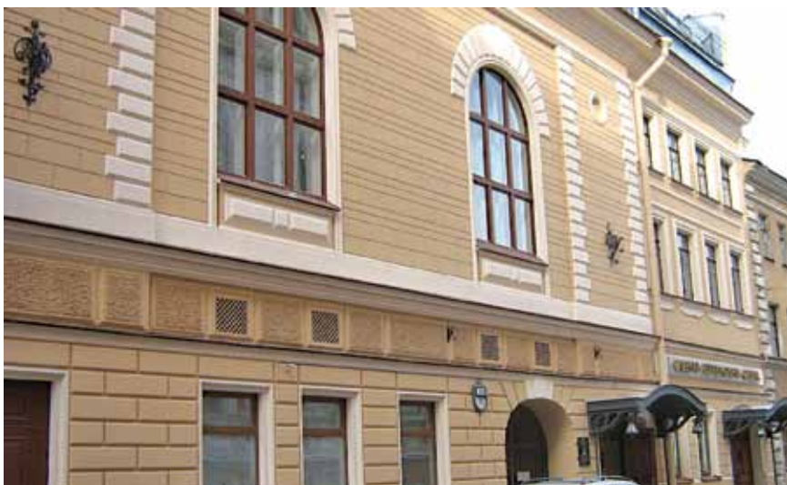
Дом С.П. фон Дервиза (сейчас Камерный музыкальный театр «Санкт-Петербург Опера» на Галерной ул., 33) — Польский Дом просвещения располагался здесь в составе Дома культуры народов Западного фронта с февраля по октябрь 1937 г.
