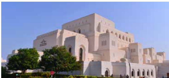
Nowoczesna architektura nawiązuje do starych fortec
