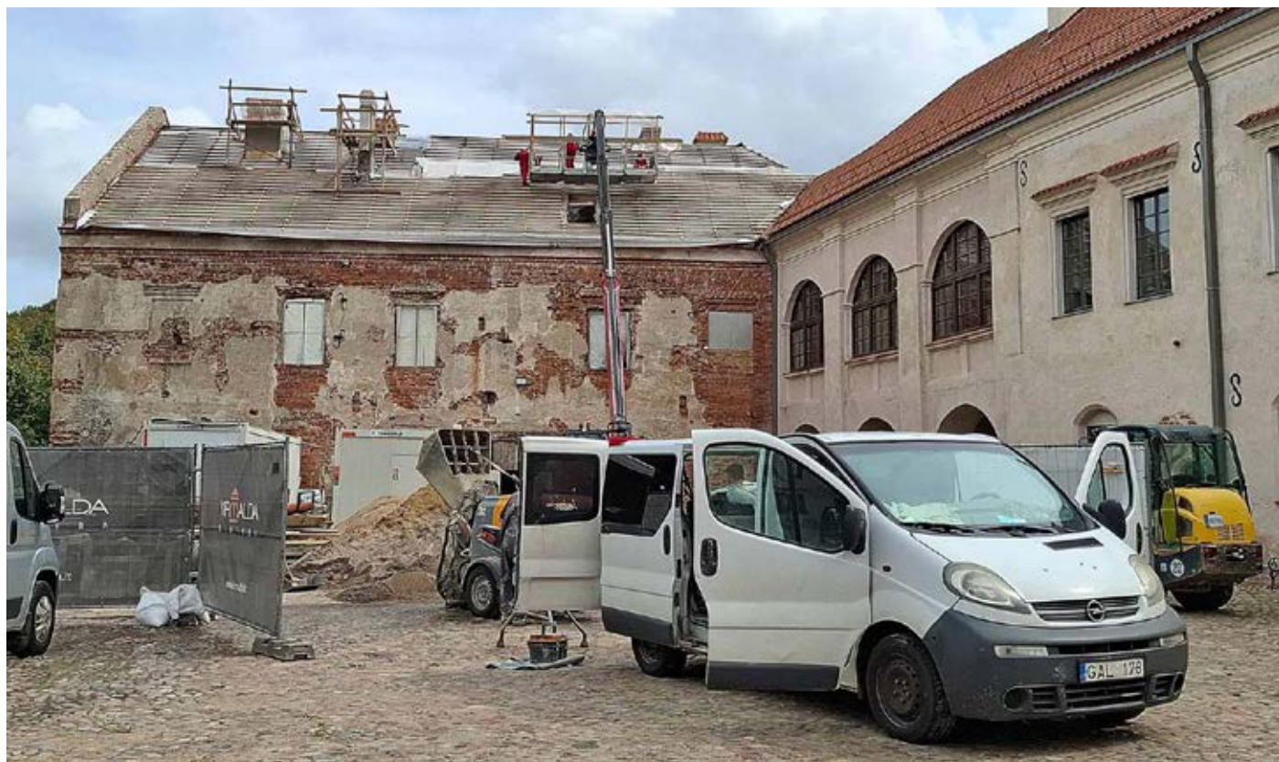
W Poniemuniu trwają prace przy rekonstrukcji trzeciego zamkowego skrzydła Fot. autor
