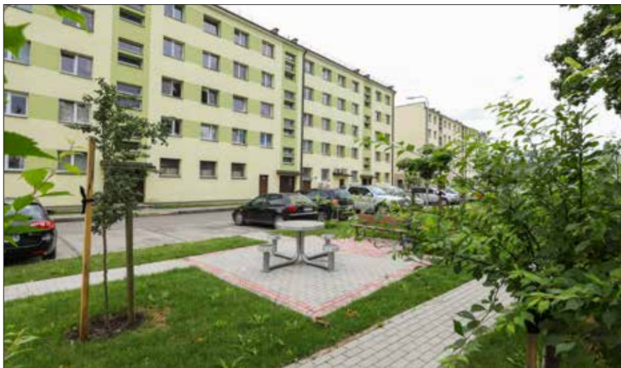
■ Renowacja budynków mieszkalnych na Litwie Fot. z archiwum APVA
