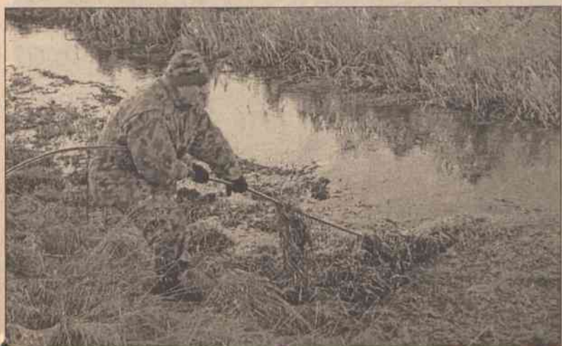
Ogólna długość tego rurociągu była zaskakująca i dotychczas niespotykana — ogółem od granicy z Białorusią na terytorium Litwy miała ona ponad 3 km
