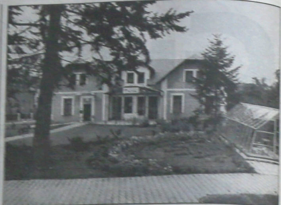
▲ Jeden z ośrodków opieki Diakonii Śląskiej „Betezda” w Ligocie Kameralnej po gruntownym remoncie. Fot. FRANCISZEK BALON
