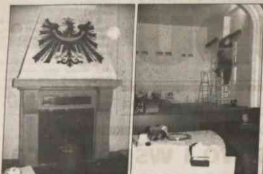
▲ Podczas remontu sali kinowej w jabłonkowskim ratuszu odnurzony został również kuminek ze śląskim czarnym orłem. ♦ Ostatnie prace na nowej scenie.
