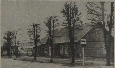
Budynki szkolne: nowy (na dalszym planie) i stary, z 1960 roku.
