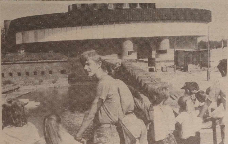
Przy Morskim Muzeum-Akwarium w Kłajpedzie powstała oryginalna budowla — delfinarium, zaprojektowane przez architekta Petrasa Lapę i konstruktora Tautvydasa Tubę. Dobięga już końca wyposazanie tego jednego z największych w Europie delfinariów, a w sierpniu rozpoczyna się występy treshowanych delfinów.
