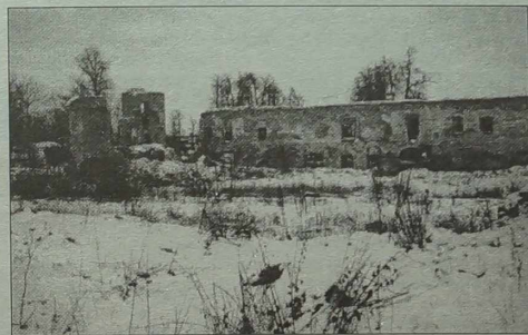
Ruiny zamku - stan obecny
