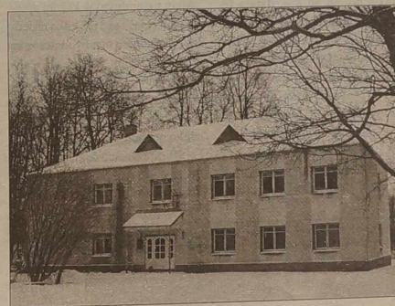
Pałacik nowego właściciela zbudowany na starych fundamentach.
