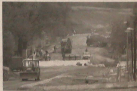
▲ Trwają prace na drodze II/476 z Trzyna do przebiegu granicznego w Lesznej. Ich zakończenie zaplanowano na marzec 2004. Fot. D. BRANNA
