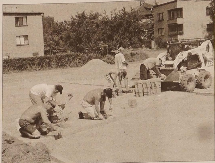
Powstający naprzeciw budynku poczty w Bystrzycy parking samochodowy powinien rozwiązać problem z brakiem miejsc parkingowych w centrum gminy.
