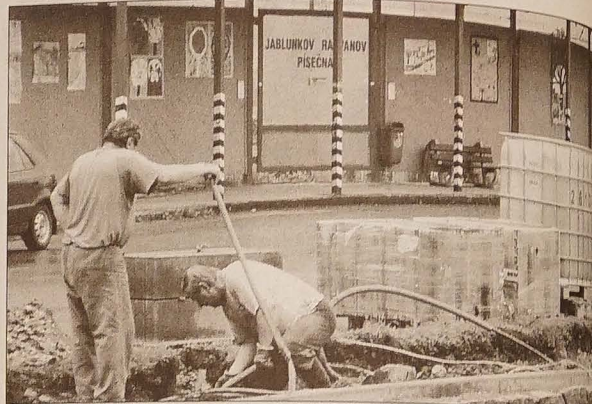
Rozpoczął się remont chodników w Nawslu. Na naszym zdjęciu prace przy chodniku przed hram autobusowym, gdzie równocześnie jest zmieniane oświetlenie publiczne. W tle widać „galerię na świeżym powietrzu” – drewniana ściana przy peronie dworcowym została wybudowana do prezentacji prac nawleskich dzieci.
