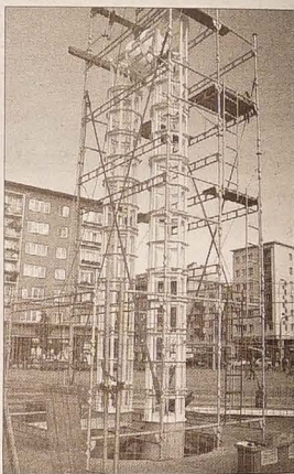
Gotowy jest już 9-metrowy szkielet r... teraz kolej na montaż poszczególnych części.
