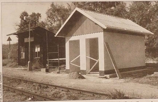
Nowe zabudowanie wyrosło niedawno na przystanku Ropica Zalesie. Zastąpiło ono dawną budowlę wyburzoną w ub. roku oraz murowaną, którą dopiero co rozebrano. Linia kolejowa, prowadząca przez Ropice doliną rzeki Ropiczanki, która pierwotnie łączyła Bielsko z Ciesznym i Frydkim, wybudowano w 1886 r. Przystanek Ropica Zalesie wybudowano w 1954 r. Z powodów praktycznych wymogli go sobie mieszkańcy tej części Ropicy i Trzycie.
