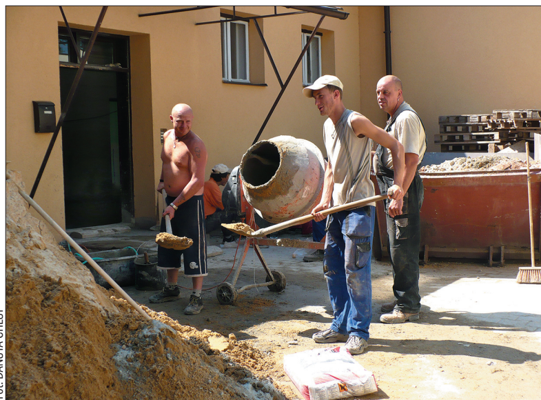
Pracownicy firmy VAPES przed środkową częścią polskiej szkoły w Stonawie, która z powodu szkód górniczych musiała zostać wzmocniona żelbetonową płytą.
