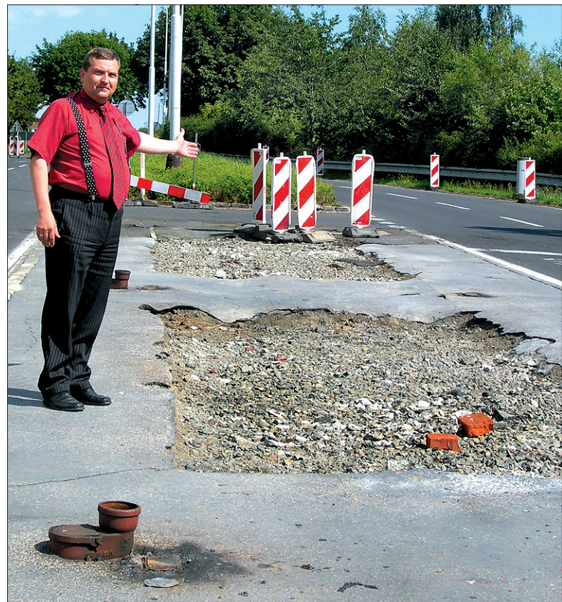
Tu, w tym miejscu, stały budki kontroli paszportowo-celnej w Karniowie – wskazuje Karol Siwek, stojący na czele regionalnego oddziału Urzędu ds. Reprezentowania Państwa w Sprawach Majątkowych. Dziś znajdują się tu tylko wyrwane z betonu piaskowe placki.
