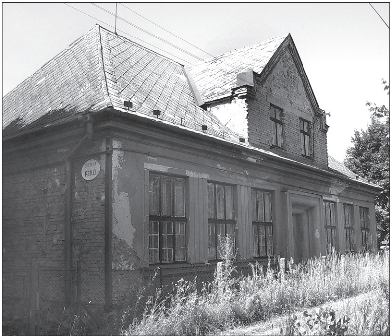
Świetlica PZKO w Karwinie Sowińcu.
