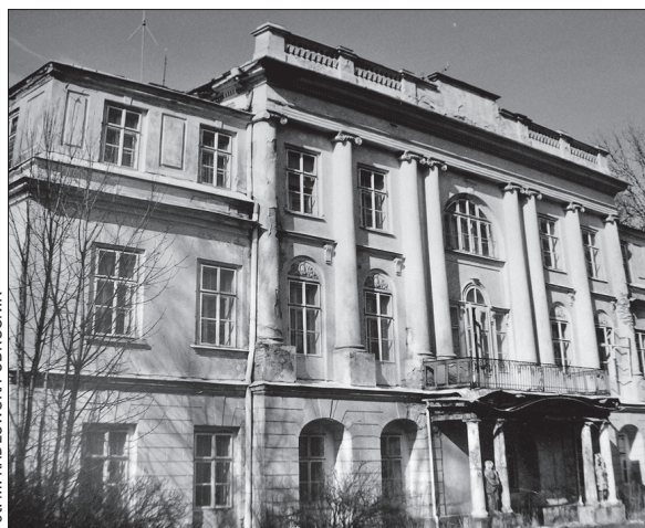
Pałac w Gnojniku ma już nowego właściciela.
